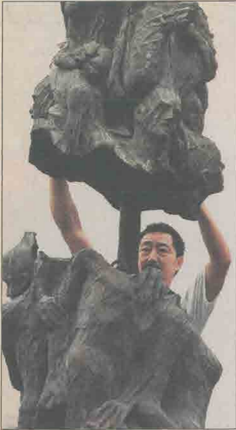
工人正在維園安裝國殤之柱。
